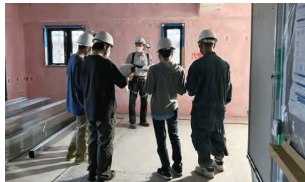
建設現場見学会の様子
