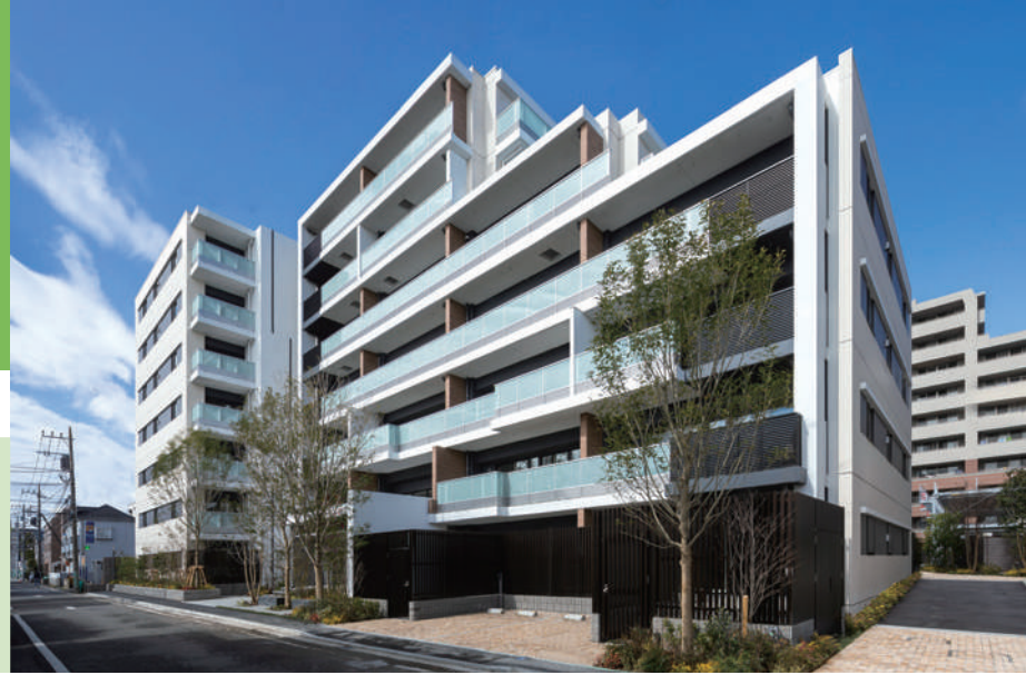
クリオ レジダンス横濱綱島 (2022年3月竣工)
