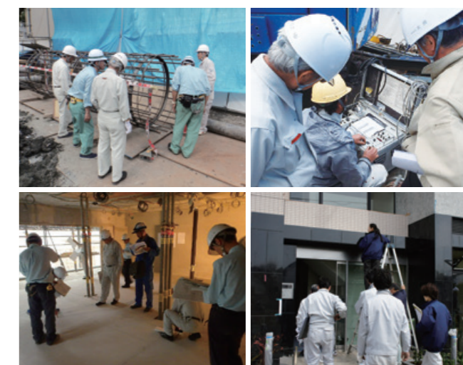
各施工段階での検査
