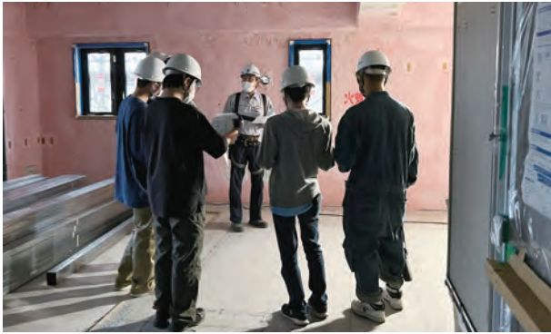
建設現場見学会の様子
