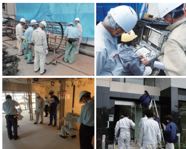
各施工段階での検査
