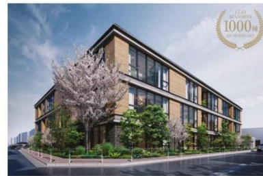
▲外壁を木質化した初の分譲マンション (クリオ桜新町ザ・クラシック)
