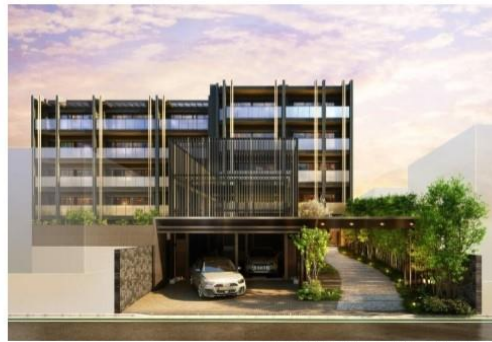
埼玉県川越市 総戸数50戸 2023年7月竣工・引渡し
