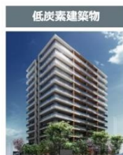
クリオレジダンス川崎南幸町 (2024年竣工)
