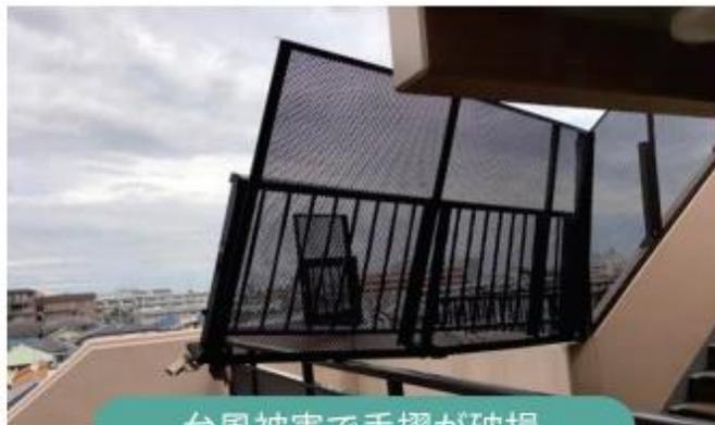
台風被害で手摺が破損
