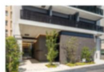
クリオ ラベルヴィ 名古屋花の木 所在地：愛知県名古屋市 総戸数：28戸
